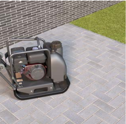
Afrillen met trilplaat voorzien van rubberen zool
