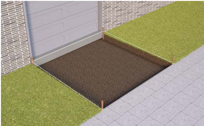
Uitzetten met piketten en niveau bepalen
