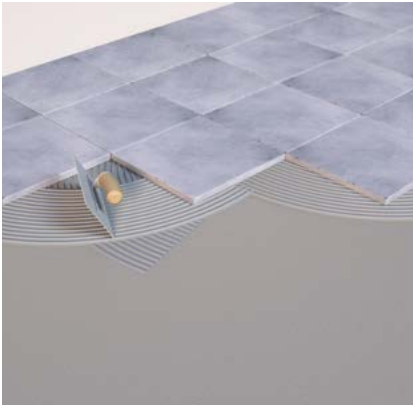
Plaatsing tegels met tegellijm
