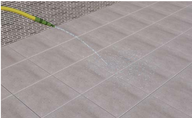
Besproeien met water alvorens te reinigen
