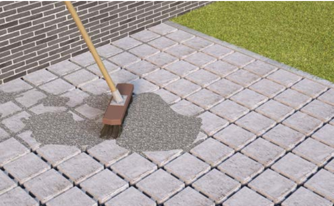
Opvullen met waterdoorlaatbare voegsplit
