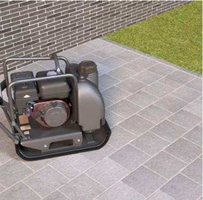
Afrillen met trilplaat voorzien van rubberen zool
