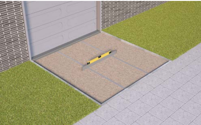
Fundering straatlaag, nivelleren met paslatten
