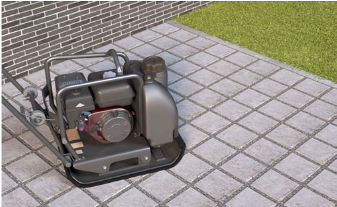
Aftrillen met trilplaat voorzien van rubberen zool
