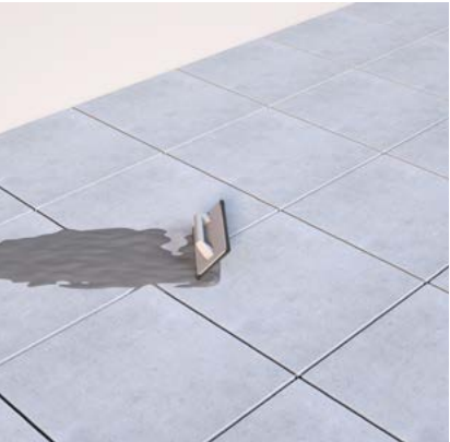
Voegen met voegmortel en voegrubber
