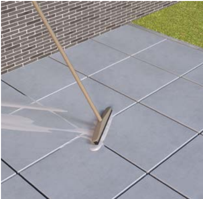
Voegen met voegmortel en voegrubber
