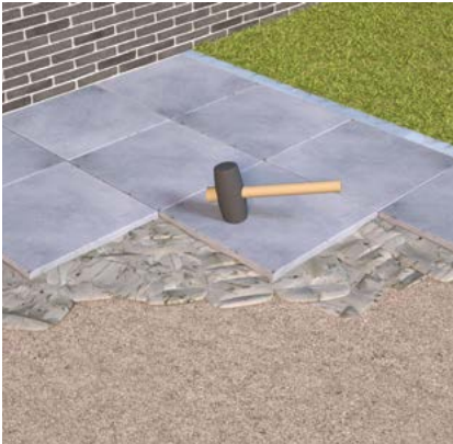
Plaatsing tegels in de legmortel op stabilisé
