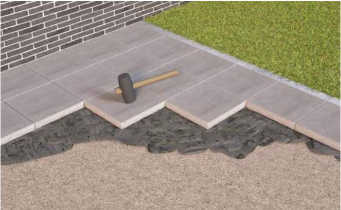
Plaatsing tegels aankloppen met rubberen hamer
